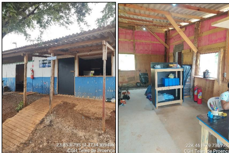
Figura 5 – Almoxarifado e refeitório.
