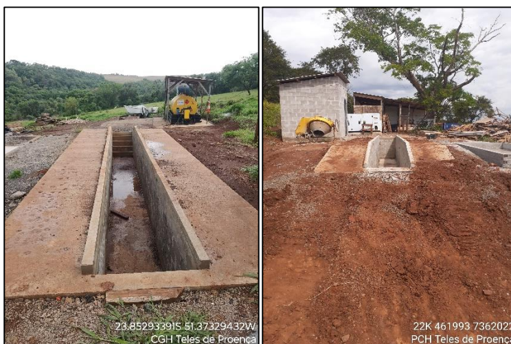
Figura 7 – Rampa de manutenção.
