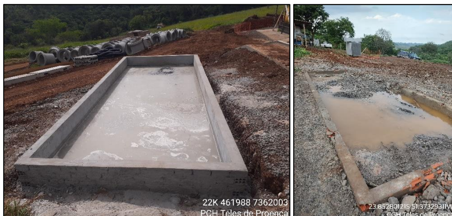
Figura 32 – Lavagem de caminhão de concreto.
