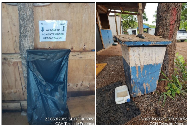
Figura 22 – Baías de acondicionamento de resíduos.
