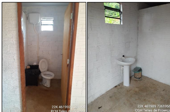
Figura 24 – Lixeiras nos Sanitários.
