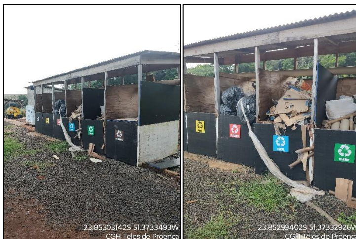
Figura 21 – Baías de acondicionamento de resíduos.
