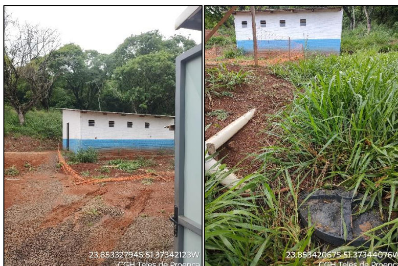
Figura 29 – Estrutura existente – escritório de engenharia.
