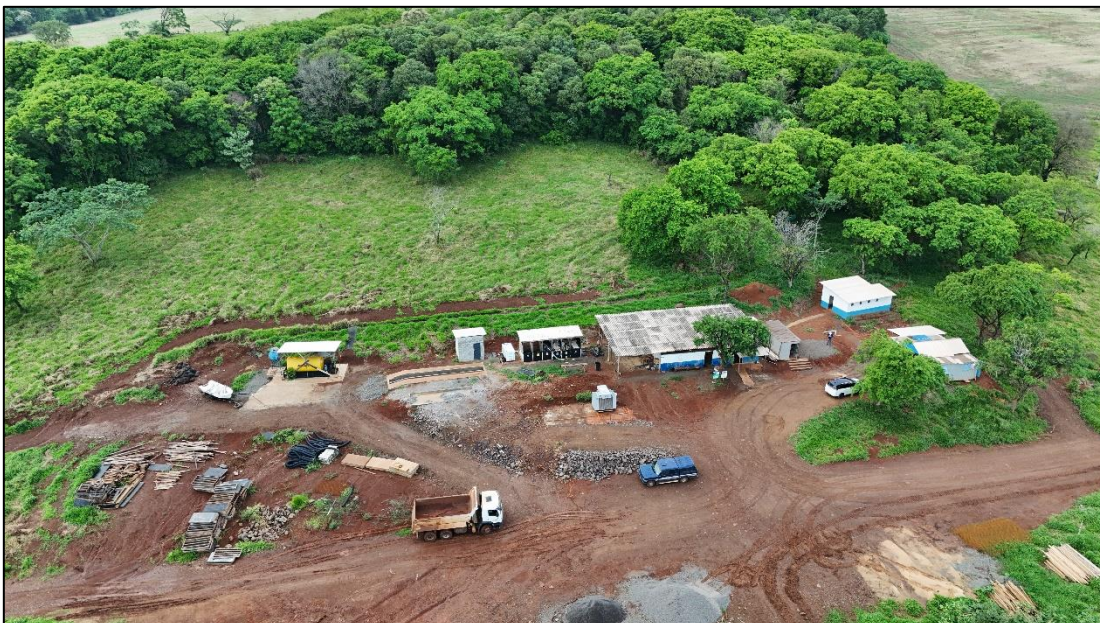
Figura 8 – Canteiro de Obras.
