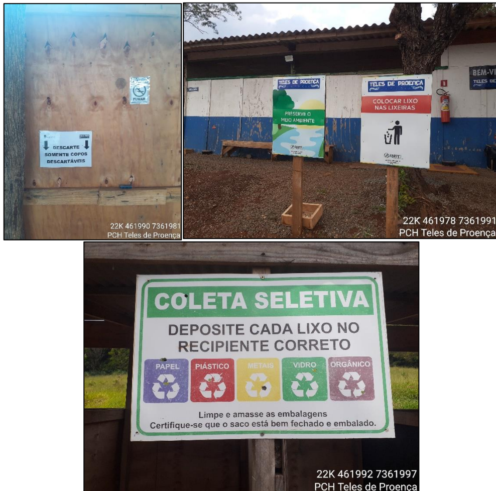
Figura 28 - Cartilha de Resíduos exposta no canteiro de obras na CGH Teles de Proença.
