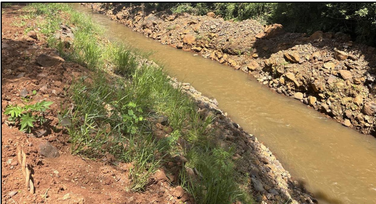
Figura 40 - Canal de fuga finalizado.
