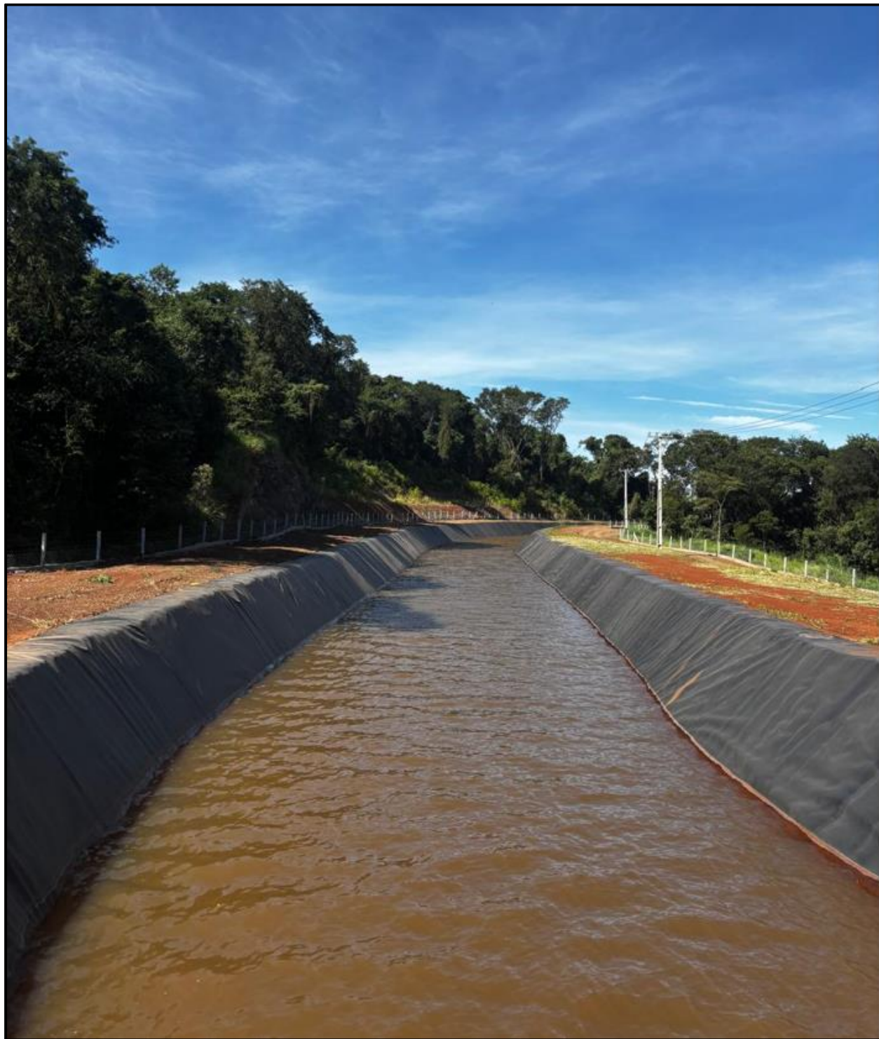
Figura 19 - Canal adutor finalizado após enchimento.
