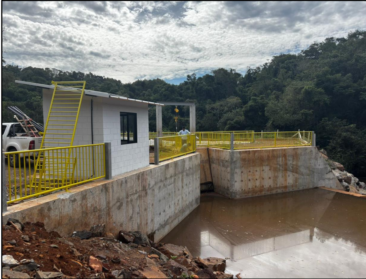
Figura 12 - Tomada d'água finalizada.
