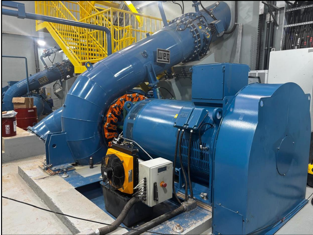
Figura 37 - Instalação das unidades geradoras finalizadas.
