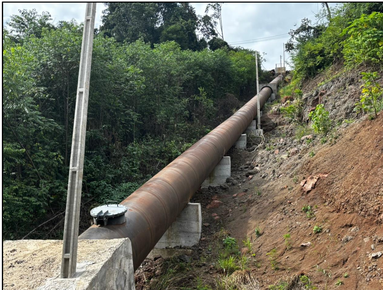
Figura 28 - Conduto forçado finalizado.
