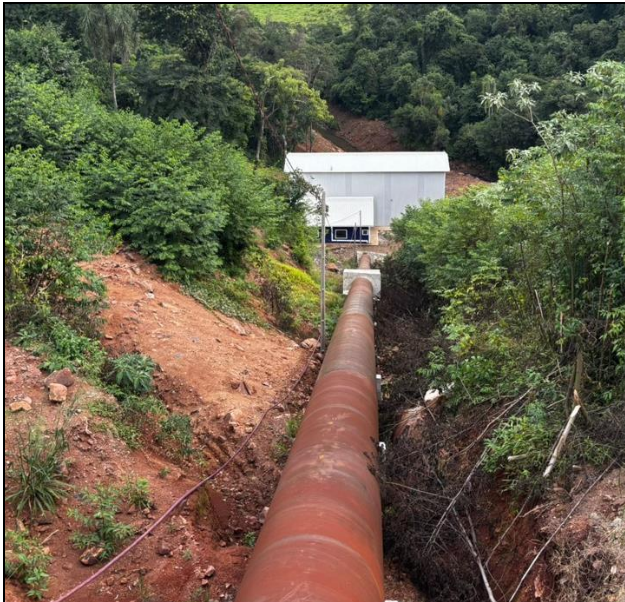
Figura 27 - Conduto forçado finalizado.
