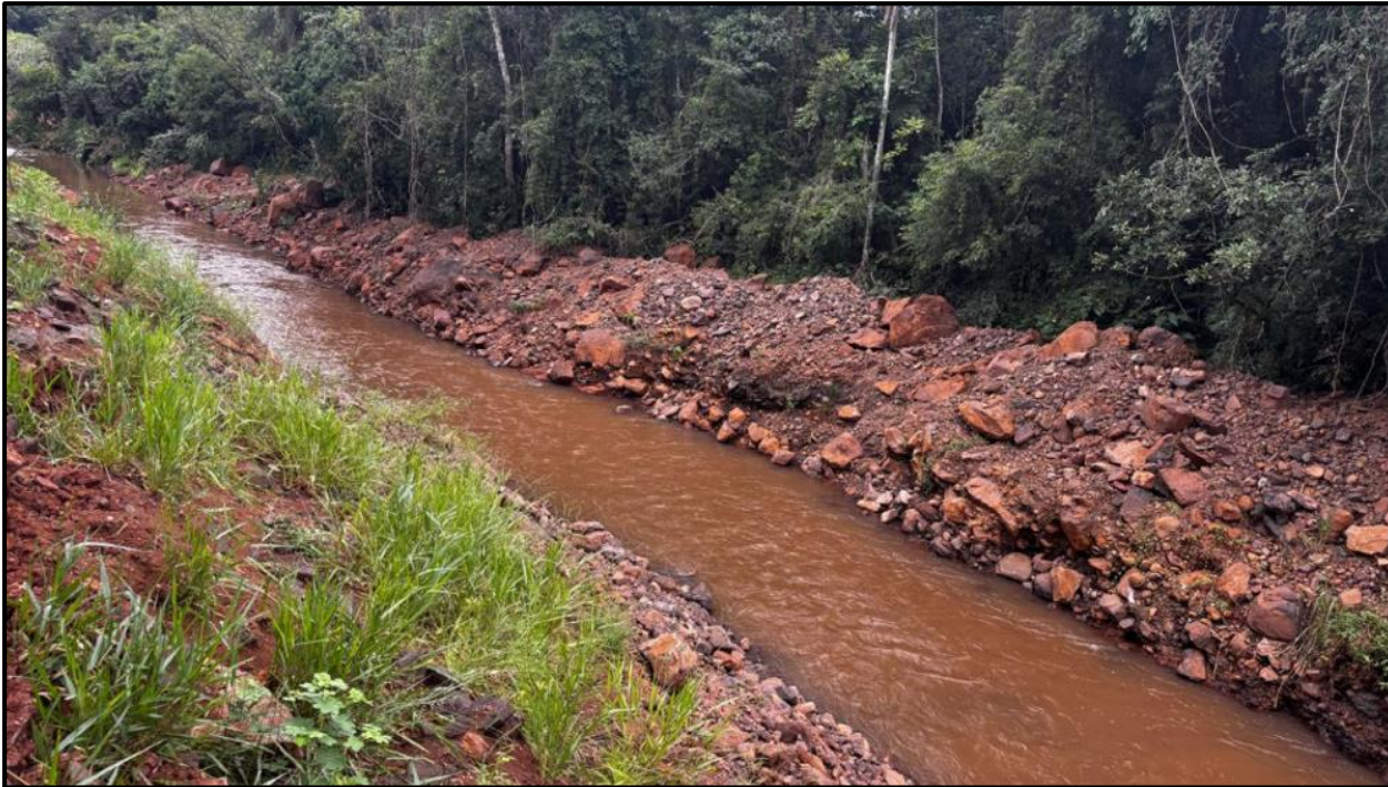
Figura 42 - Canal de fuga finalizado.
