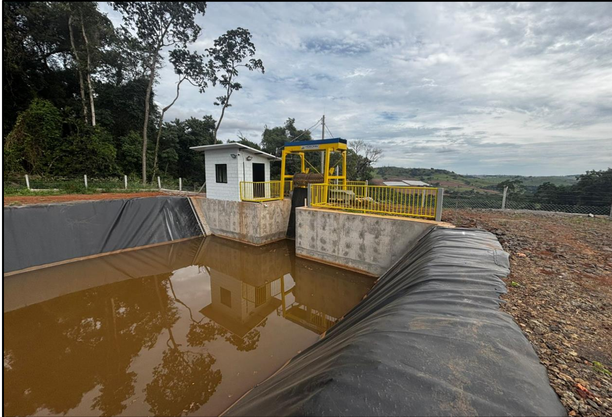
Figura 23 - Câmara de carga finalizada.
