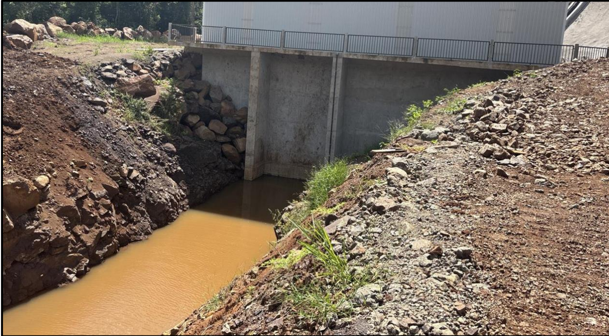
Figura 39 - Canal de fuga finalizado.
