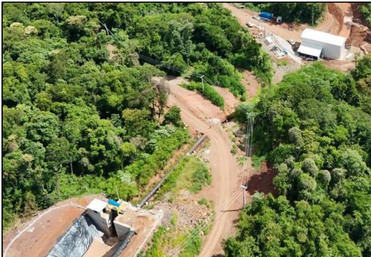
Figura 26 - Conduto forçado finalizado.
