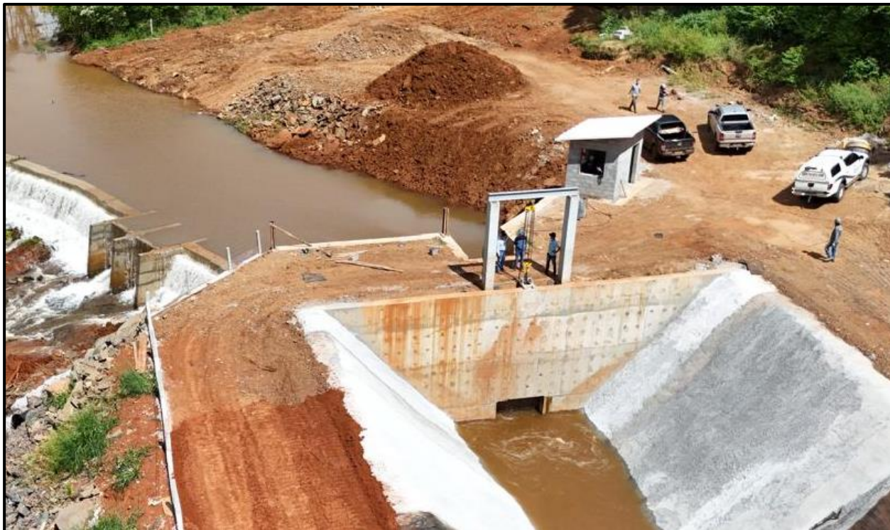
Figura 11 - Tomada d'água finalizada.
