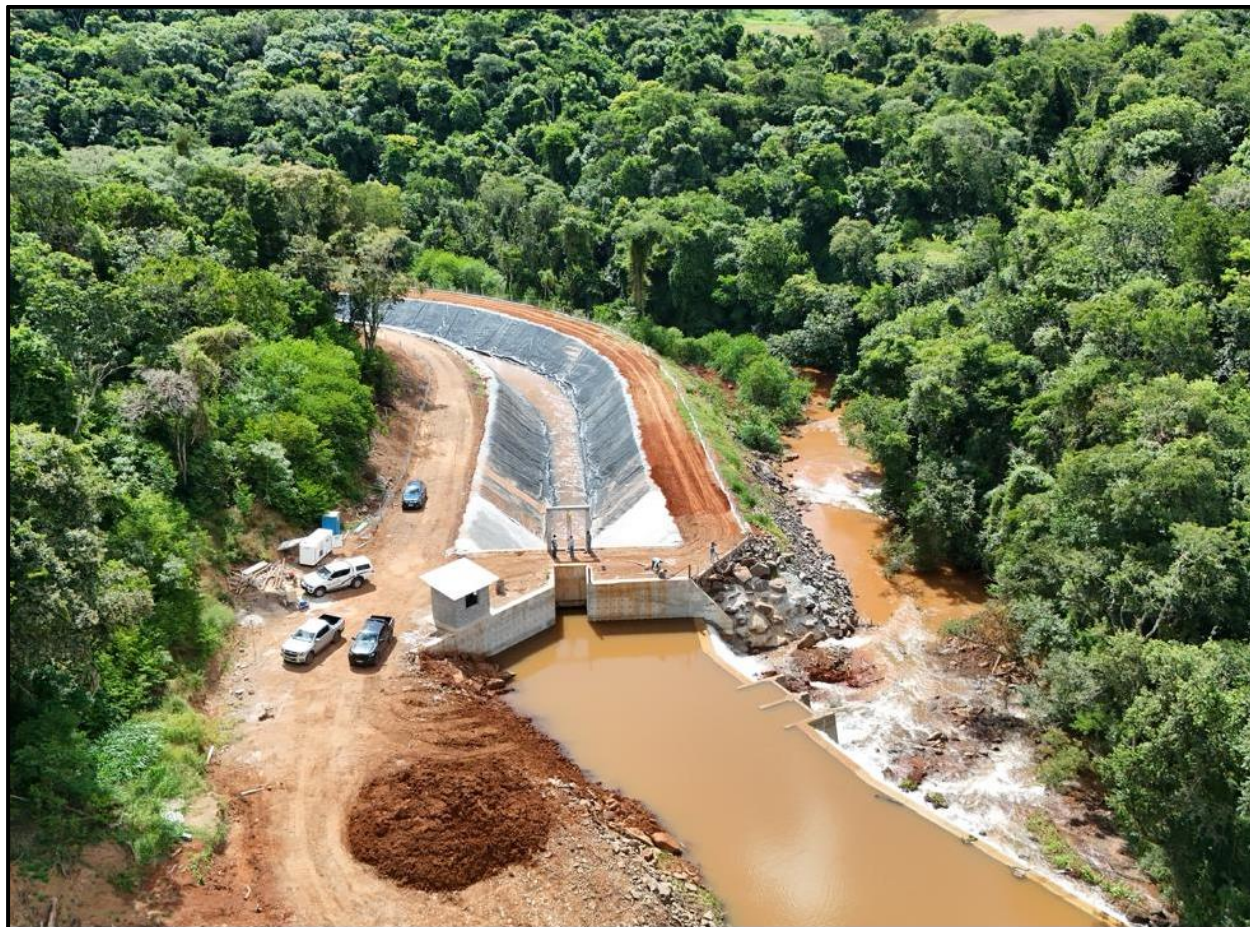
Figura 15 - Canal adutor finalizado trecho inicial.
