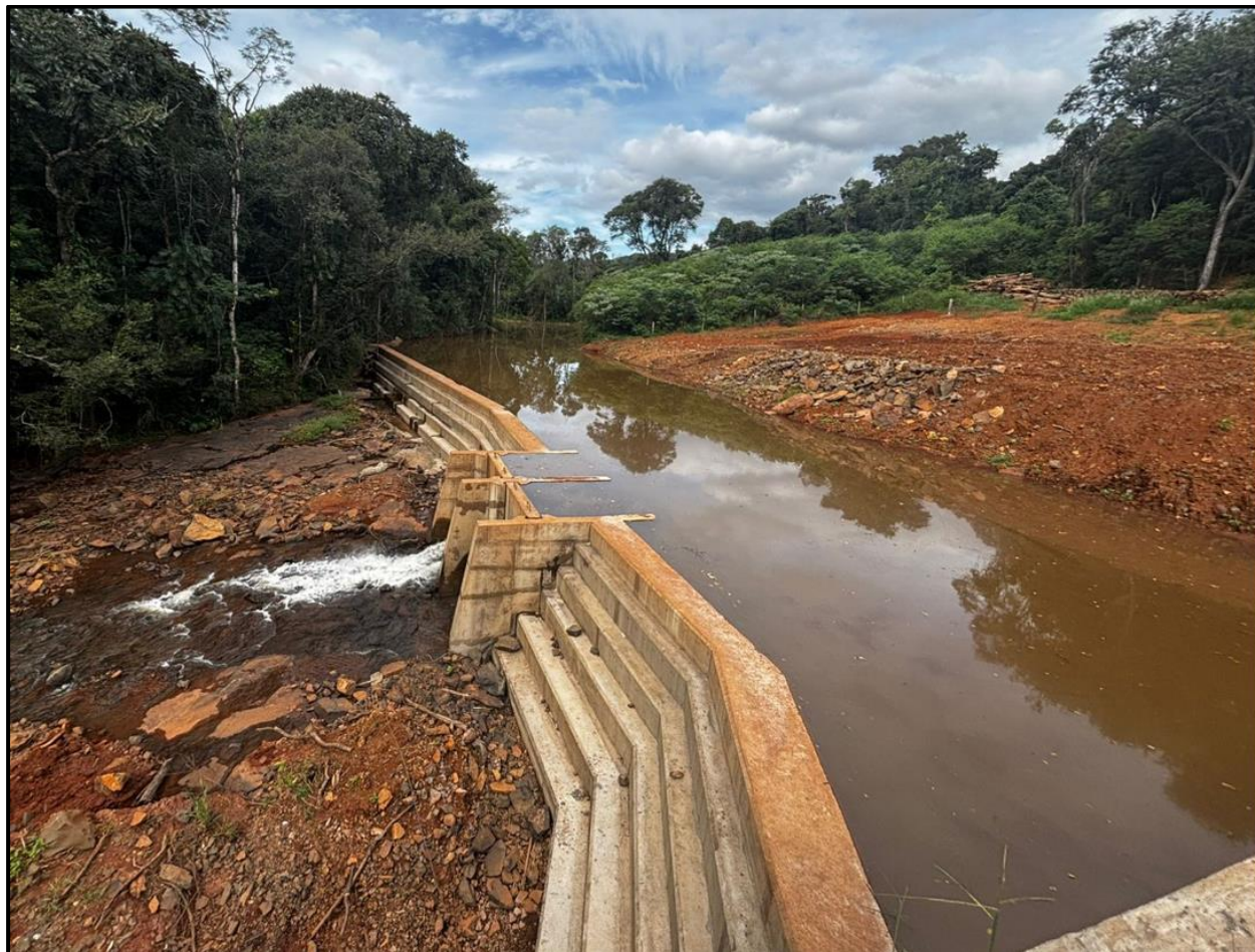
Figura 8 - Vertedouro e adufa de desvio finalizados.
