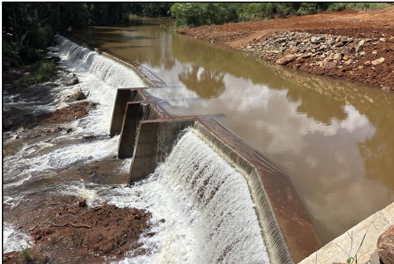
Figura 9 - Vertedouro e adufa de desvio finalizados.
