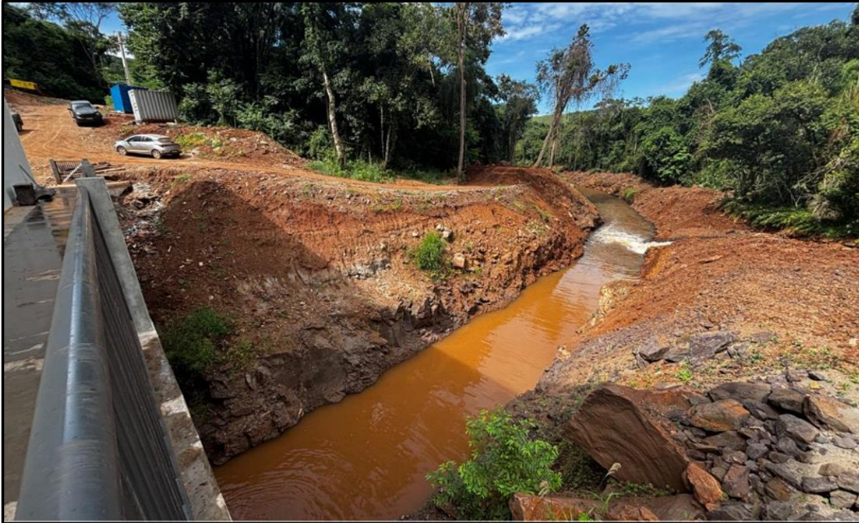
Figura 41 - Canal de fuga finalizado.
