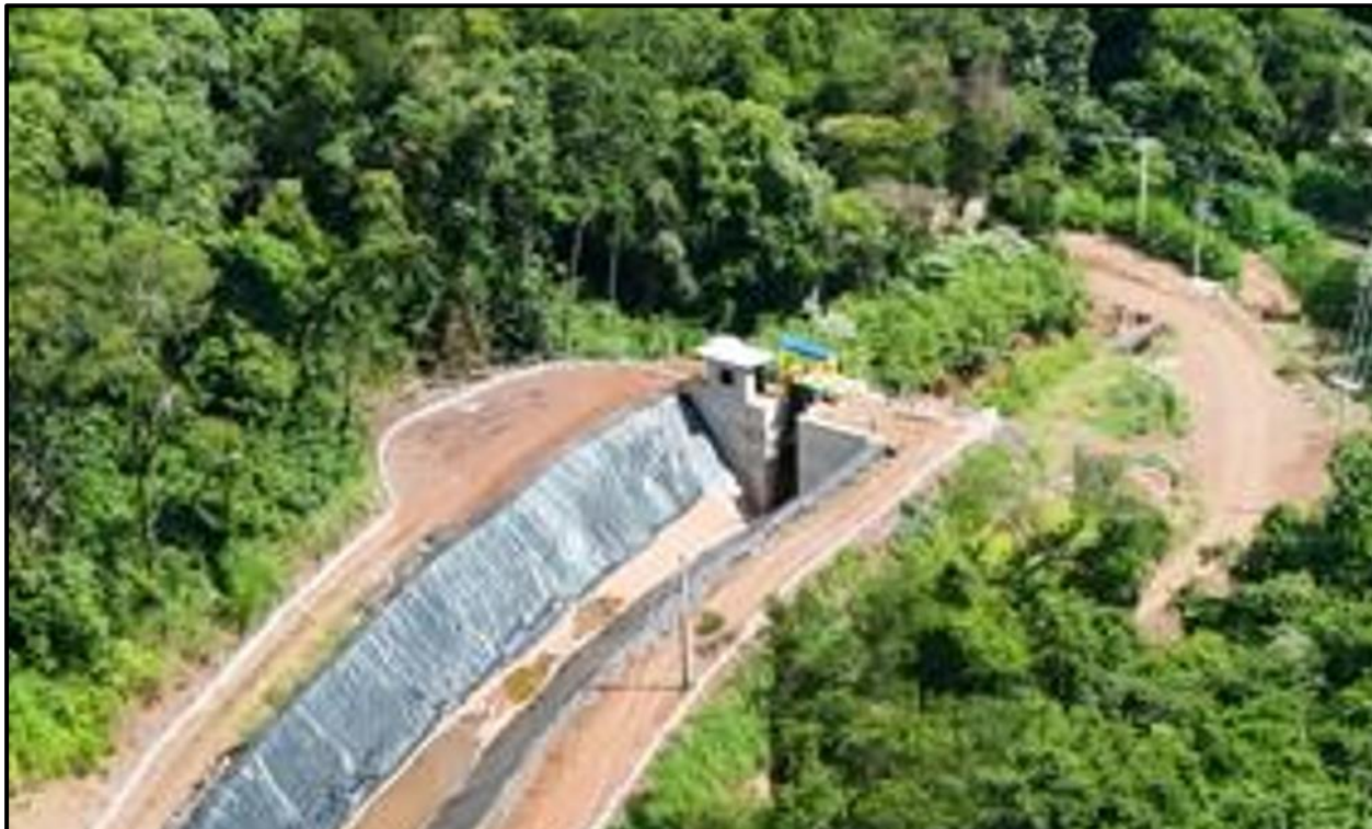
Figura 24 - Câmara de carga finalizada.
