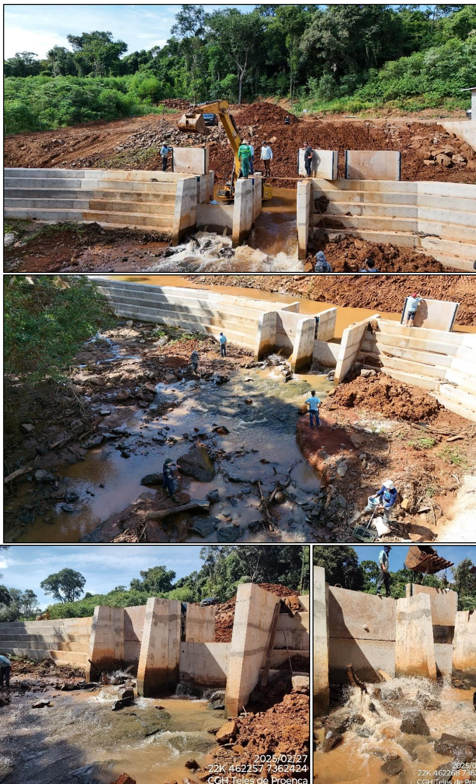
Figura 24 – Fechamento da barragem.
