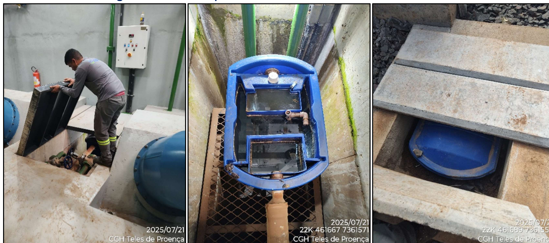
Figura 24 – Caixa separadora – Área de abastecimento
