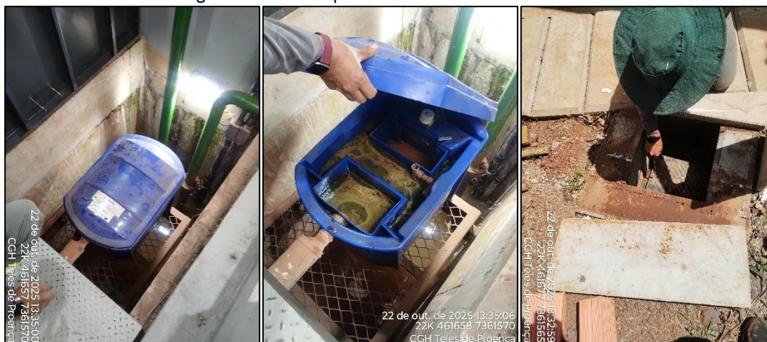
Figura 24 – Caixa separadora – Área de abastecimento
